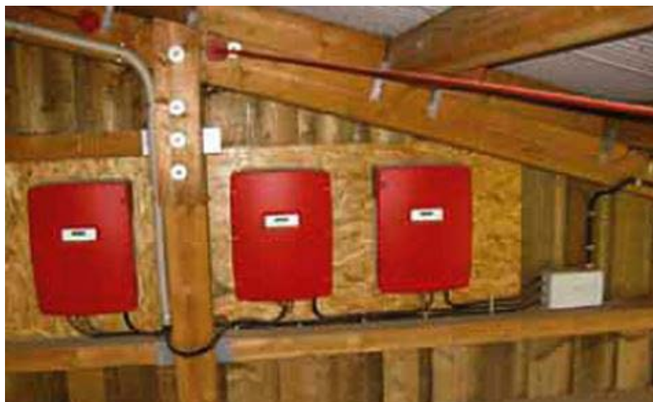
Primer neustrezno nameščenih razsmernikov na leseni podlagi (Vir: SZPV 512)
