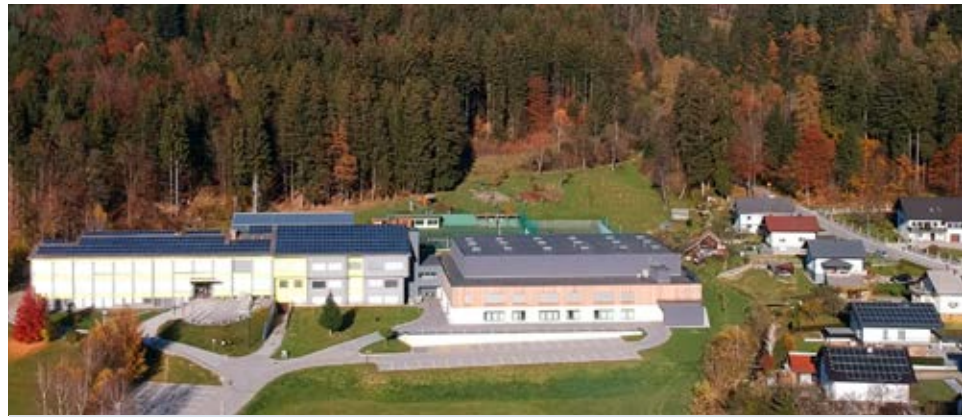
Objekti s sončno elektrarno v Mislinji. Foto: Tonči Hozjan.
